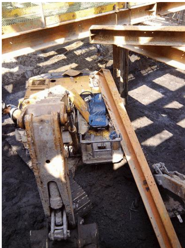
安全支撐之繫樑掉落在挖土機駕駛座上
